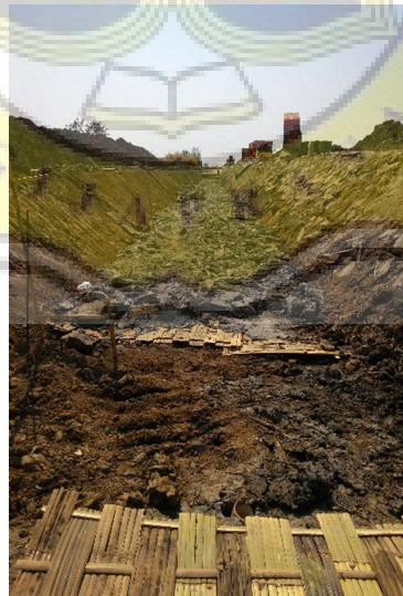
Gambar 3.13 Sesek bambu setelah disusun dicor dengan batu belah
