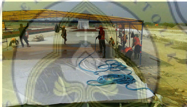
Gambar 3.51 Perawatan Rigid dengan melapisi Biotextile (Sumber : Dokumentasi Pribadi)
