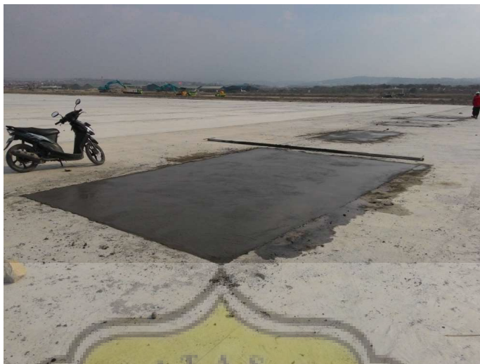
Gambar 3.70 Lean Concrete Setelah Pengecoran Kembali
