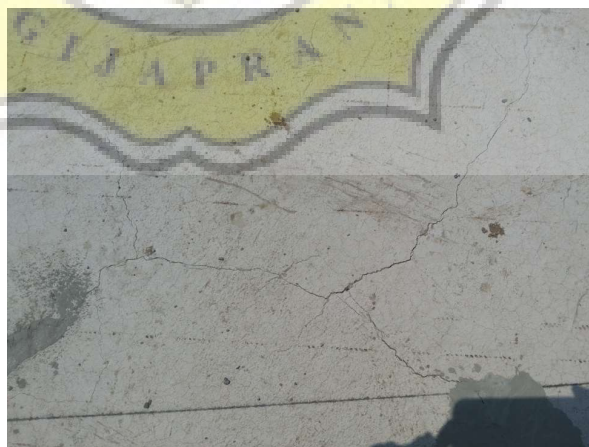
Gambar 3.66 Keretakan pada Lean Concrete (Sumber : Dokumentasi Pribadi)
