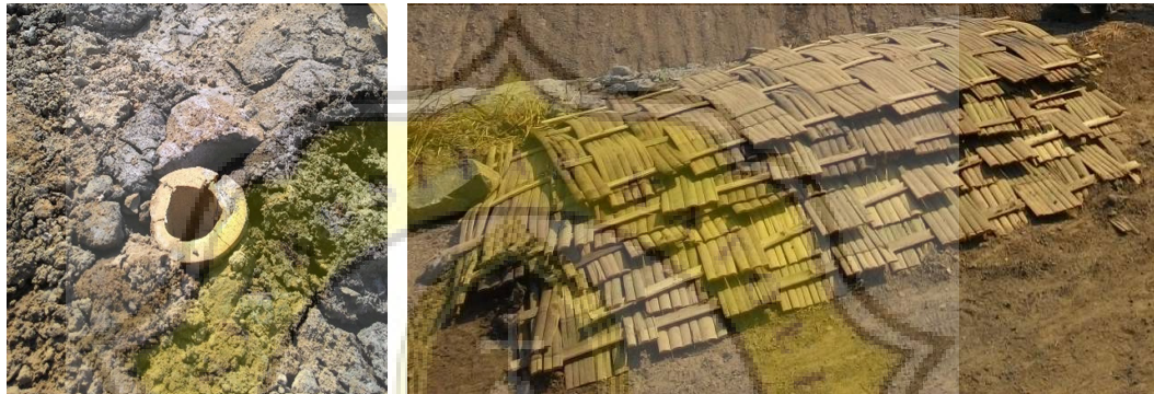
Gambar 3.10 Cerucuk bambu dan sesek bamboo
