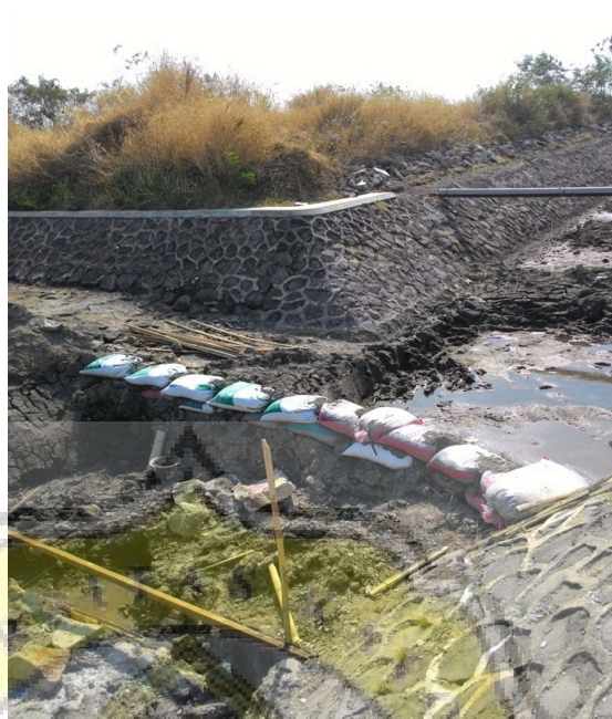
Gambar 3.65 Tanggul sederhana penghalang genangan air (Sumber : Dokumentasi Pribadi)
