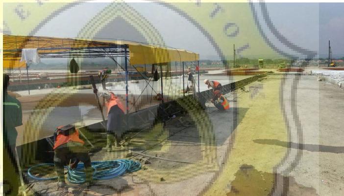
Gambar 3.61 Tenda untuk melindungi Beton dari air Hujan (Sumber : Dokumentasi Pribadi)
