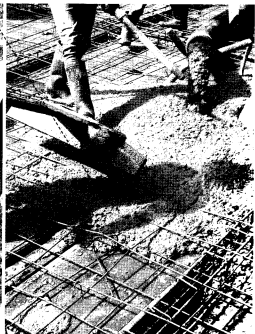
Pengecoran beton besi bertulang
