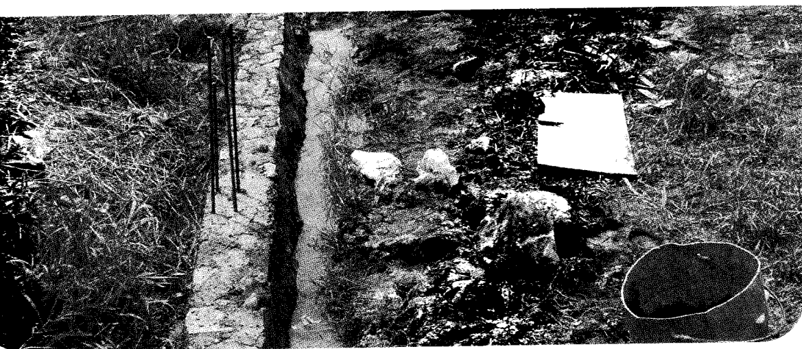
Gambar pemasangan fondasi batu kali
