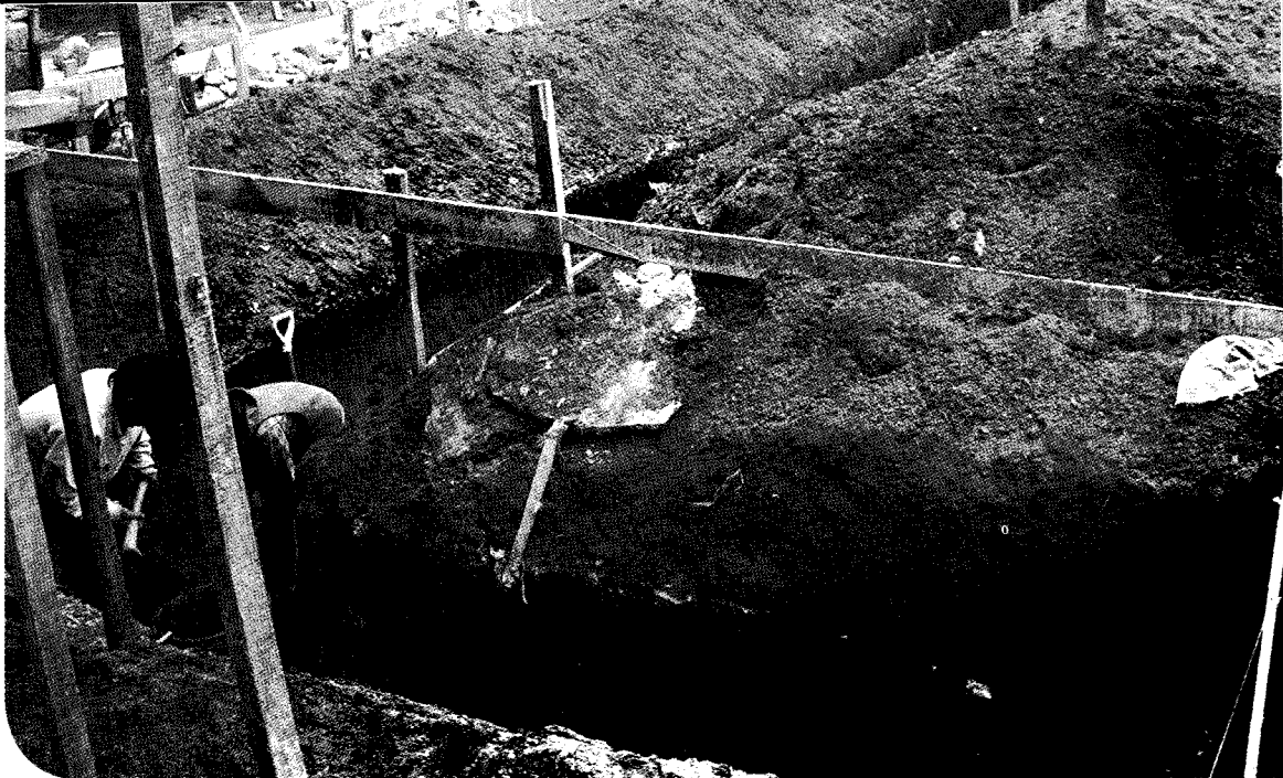
Gambar urugan pasir bawah fondasi
