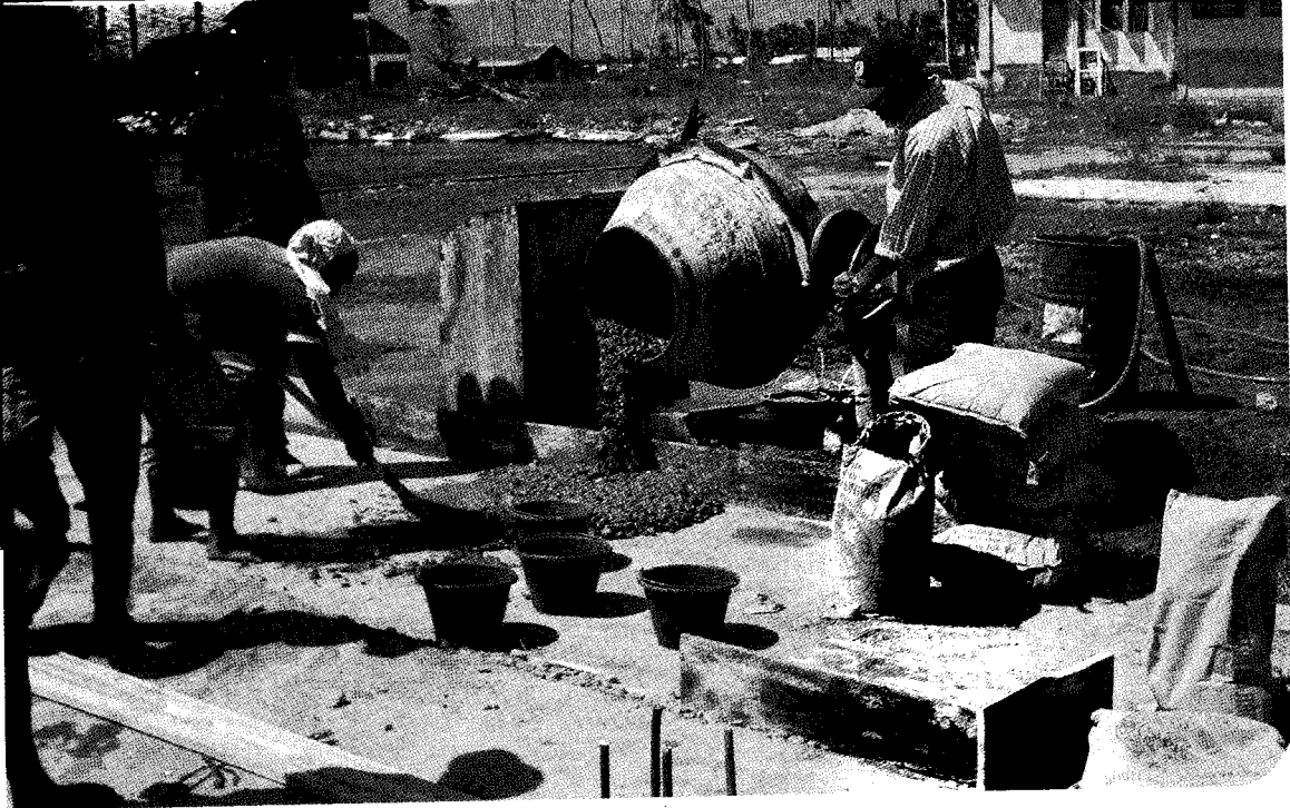
Pekerjaan pengecoran lantai kerja sebagai pengecoran awal
