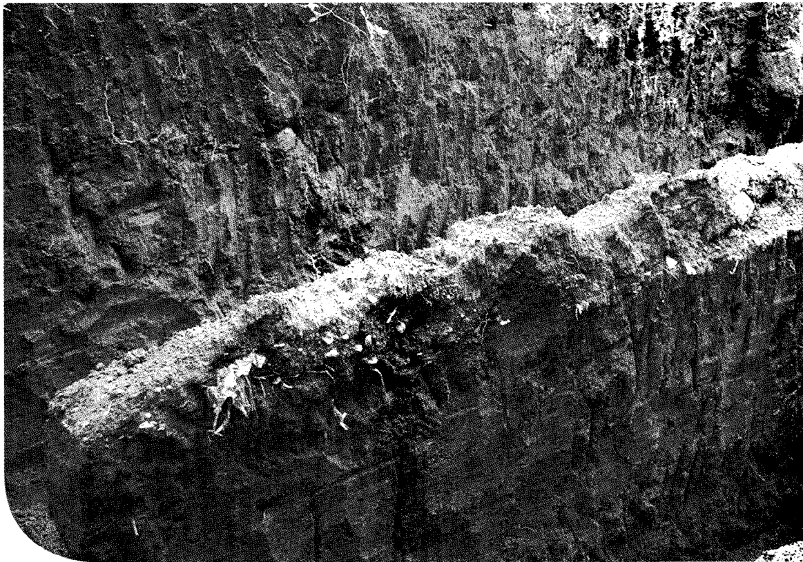
Penggalian tanah fondasi dilakukan setelah mengetahui ukuran boplang secara tepat
