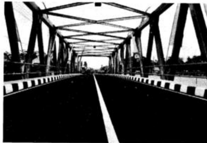
Contoh Jembatan Rangka Baja Konvensional (rangka baja Austria, rangka baja Australia, rangka baja Belanda, rangka baja Callender Hamilton, rangka baja Bukaka, rangka baja Spanyol dan lain-lain).
