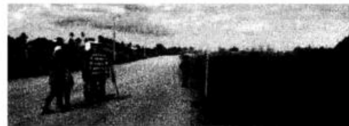
Gambar proses pengukuran timbunan tanah dengan alat ukur waterpass
