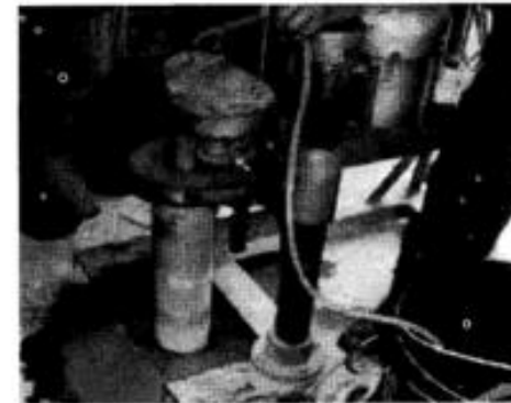
Gambar tenaga ahli sedang melakukan core drill beton plat lantai
