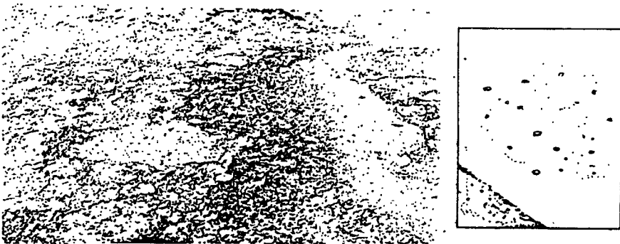
Gambar 8.16. Pelepasan butir ( ravelling )
