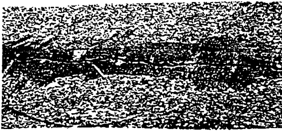
Gambar 8.4. Retak sambungan jalan (lane joint cracks)
