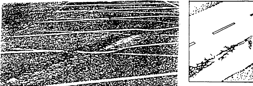
Gambar 8.17. Penurunan pada bekas penanaman utilitas
