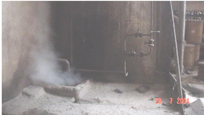
Gambar 6-8. Pengecekan steam trap secara visual.
