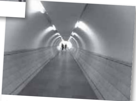
TEROWONGAN PERLINTASAN DI BELAKANG MASJID AL-AZHAR
